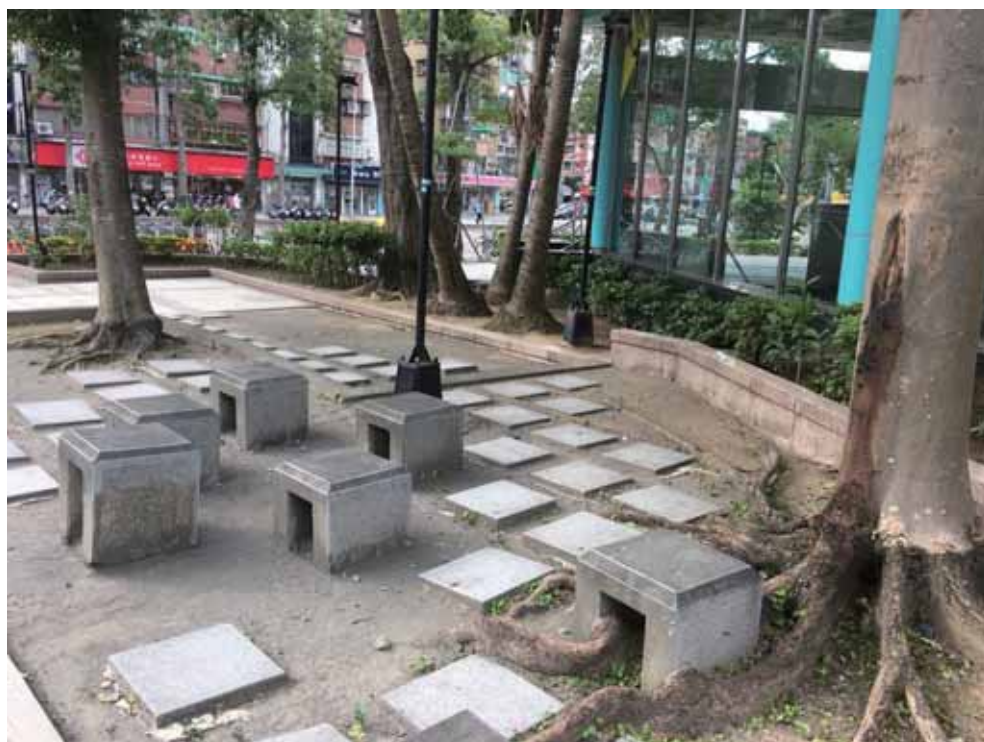
圖 1 地磚隨意散布未完整鋪設
